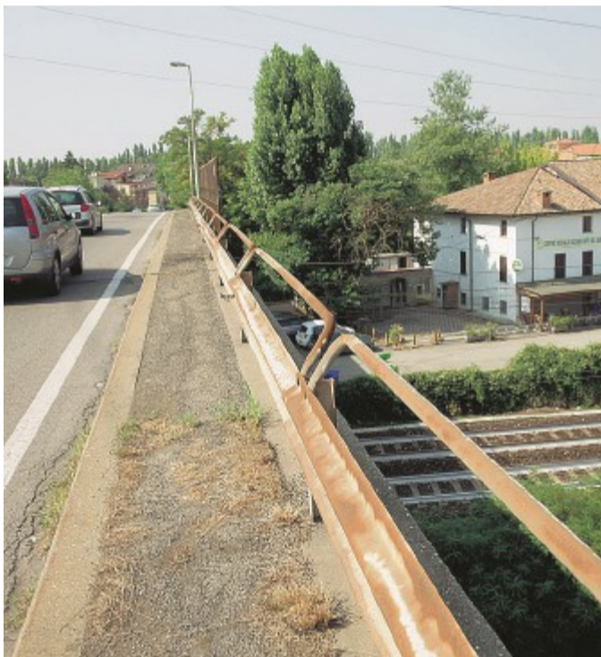
Via Mantova Il tratto di cavalcavia interessato dall'intervento.
